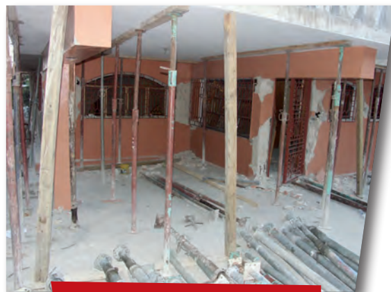
Sécurisation avec des étais de la crèche Notre Dame de la Nativité
